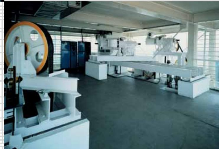
Cuarto de máquinas del montacargas para obras de arte y ascensor de servicio. Esta máquina desarrolla una potencia de 68 CV. Está situado en la planta superior de la torre trasera. Totalmente acristalado.
